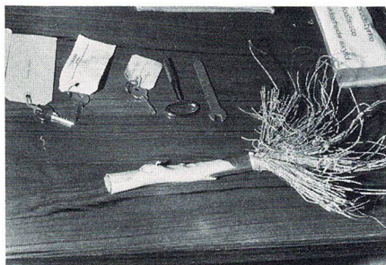
„Lykke“ når telefonkablet ødelægges dagen før indflytning på en Falck-station.
